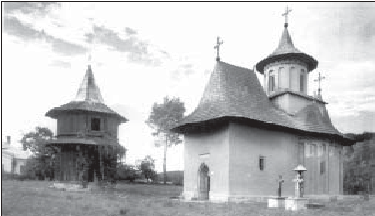
Biserica din Pătrăuți, județul Suceava. Ridicată de Ștefan cel Mare și Sfânt în 1487, reparată în 1709. Pictură interioară originală. Monument de arhitectură.
