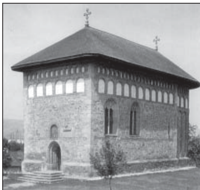
Biserica Domnească din Borzești, județul Bacău. Căminul a Voievodului Ștefan cel Mare și Sfânt și a fiului său Alexandru, din 1493 - 1494, în jurul legendarului Stejar din Borzești. Foto: Vasile Blendea
